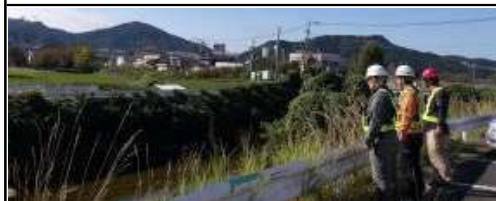
危険個所詳細 草木多い
