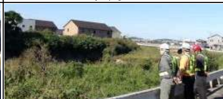
危険個所詳細 草木多い
